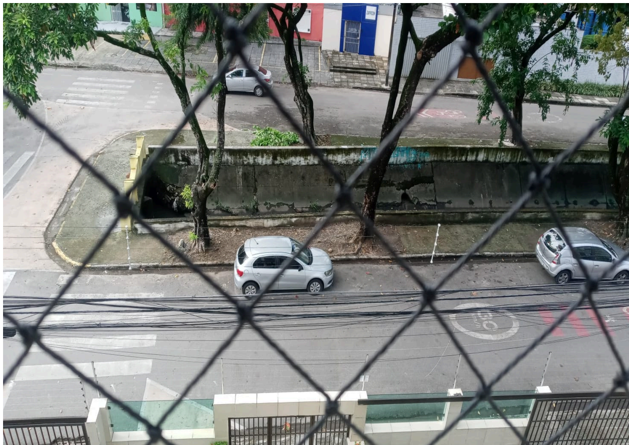
Imagem - calçada inacabada situada à Rua Ricardo Salazar, próximo ao nº 287, Madalena, Recife - PE, 54720-210.
