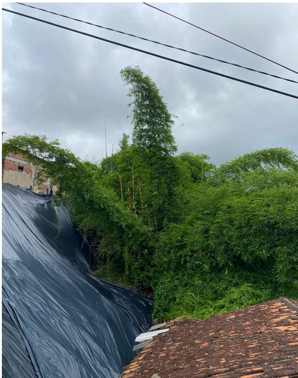
Barreira situada à Rua das Flores, 60, Alto da Colina, Coqueiral, Recife.
