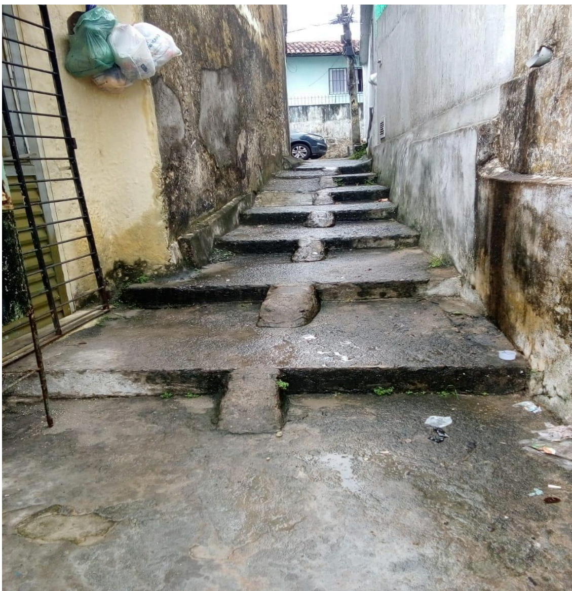
Escadaria situada à 1a Subida do Alto do Eucalipto, 6469, Vasco da Gama.
