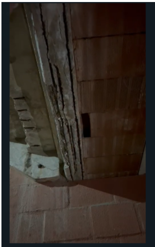
Imagem de uma coluna no interior do Bloco 20
