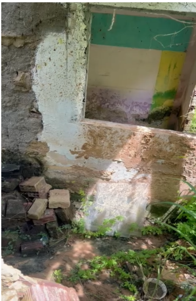
Imagem 02- Entulhos no beco situado à Rua Rua Jovem João Santos Neto, nº 404, COHAB, Recife - PE, 51280-420.
